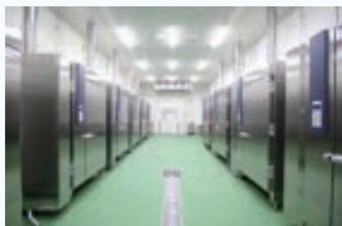
タカハシガリレイは、トンネルフリーザーを複数台納入させていただきました。下処理品冷却用と本調理品冷却用のフリーザーは、庫内の衛生管理が非常に重要となります。そのため、蒸気殺菌可能なタンクタイプのフリーザーとCIP自動洗浄※を提案し、採用いただきました。
